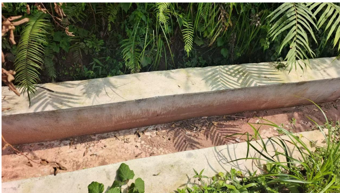
图 2.6-1 排水沟现场照片
